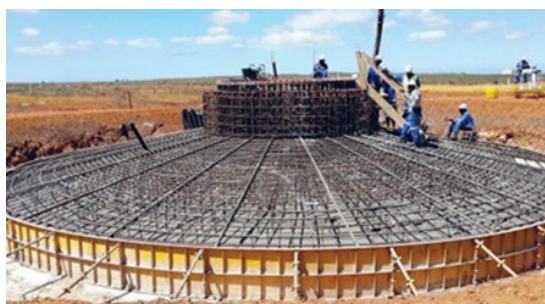
Rys. 5. Fundament bezpośredni monolityczny żelbetowy
