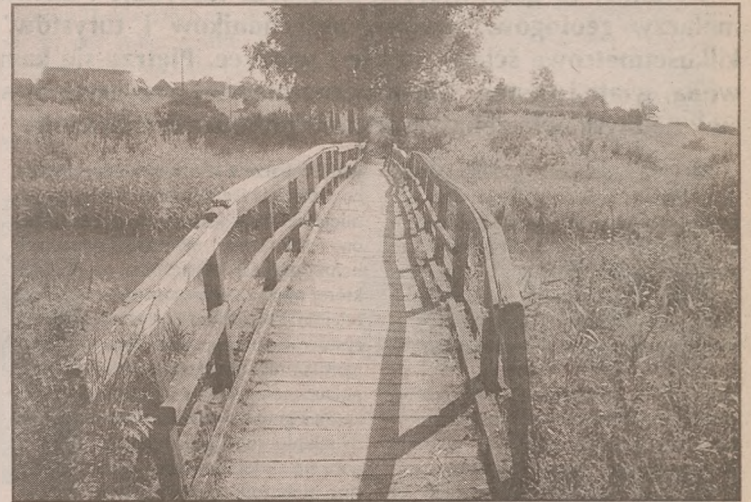
Mostek na Wełnie od strony Zrazimia
