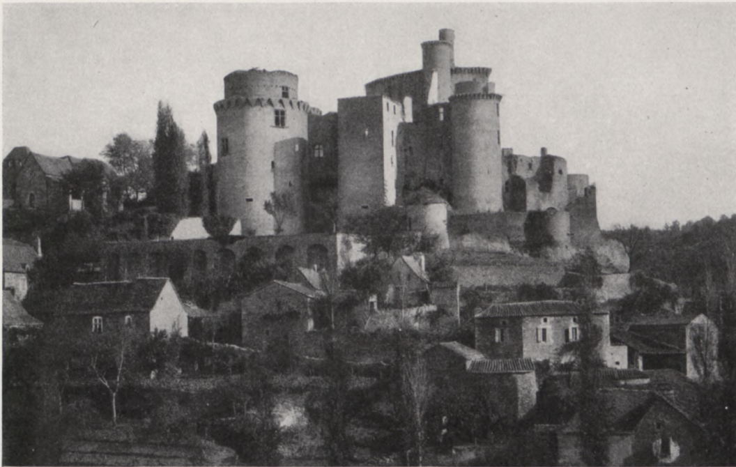
24. Schloß Bonaguil (Dép. Lot-et-Garonne), alte Feudalburg. Mitte des 15. Jahrhunderts zeitgemäß umgestaltet. Frühes Beispiel für artilleristische Einrichtungen. Zu beachten die beiden Stückpforten für Geschütze (viereckige, horizontale Öffnungen links und in der Mitte).
