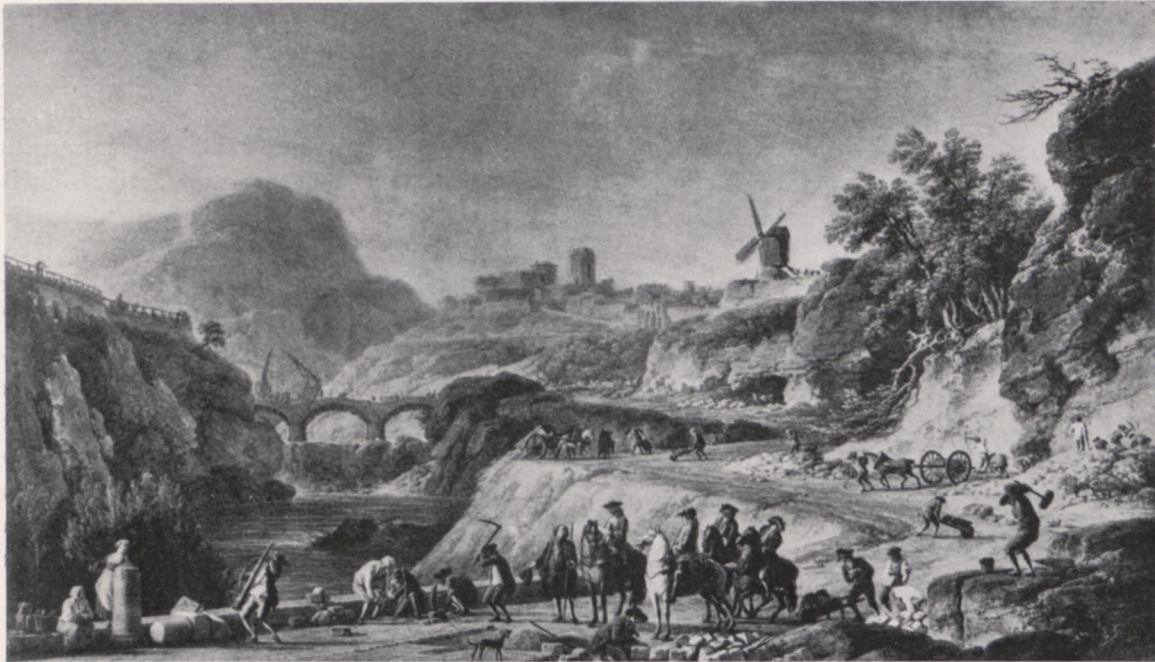
69. Bau einer Landstraße im Gebirge (1774). Nach Südfrankreich weisende Landschaft. Windmühlen dort zuerst nach 1600; jetzt fast in ganz Frankreich ausgestorben. — Im Vordergrund, zu Pferde, zwei Bauräte der Verwaltung der „Ponts et Chaussées“, der lesende angeblich der Premier Ingénieur J. R. Perronet. Gemälde von Joseph Vernet. Paris, Louvre.
