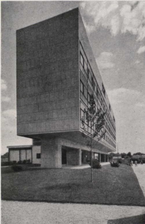
99. Aus der Pariser Cité Universitaire. Der Pavillon suisse (Südfassade) von Le Corbusier 1930—1932 erbaut. — Die Cité-Universitaire-Bewegung (seit 1925) hat in Paris (am Boulevard Jourdan), außer für Franzosen, für zahlreiche Nationen Studentenhäuser zum Zusammenwohnen entstehen lassen. Die Universität Paris zählte 1934 unter 28000 Studierenden 8000 Ausländer. — Nach Le Corbusier u. P. Jeanneret, Ihr gesamtes Werk II (1935), S. 78.
