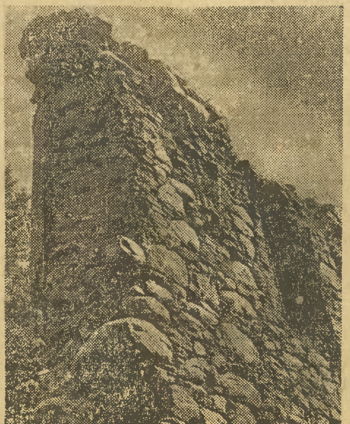
Olbrzymie, pionowe mury, zbudowane z cegły i głazów granitowych.
